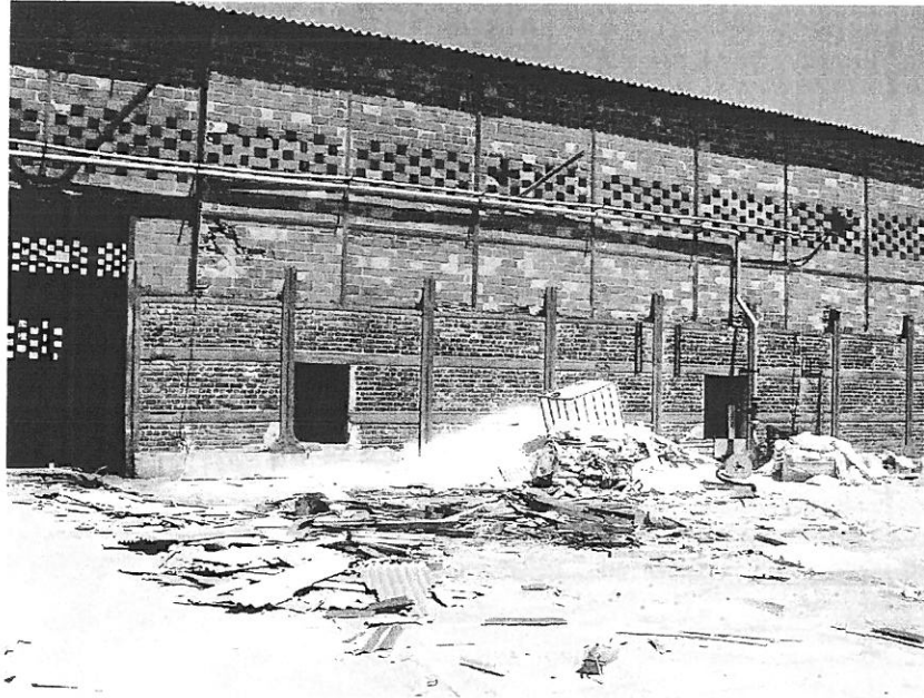
Bâtiment n°15 : Façade Sud-Ouest.
