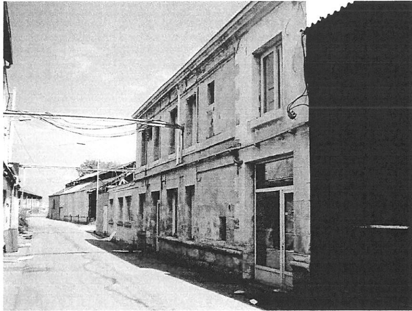
Bâtiment n°6 : Façade Sud-Ouest.
