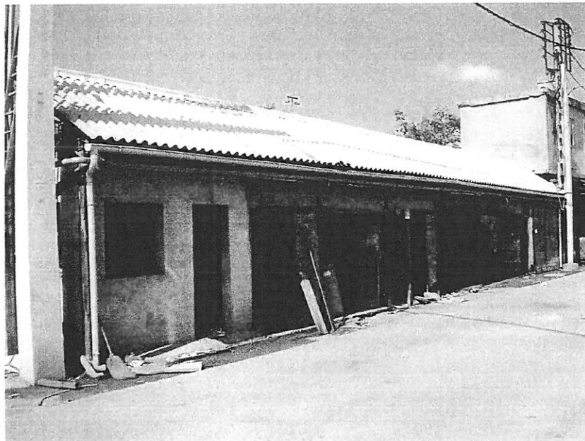
Bâtiment n°8 : Façade Nord-Est.
