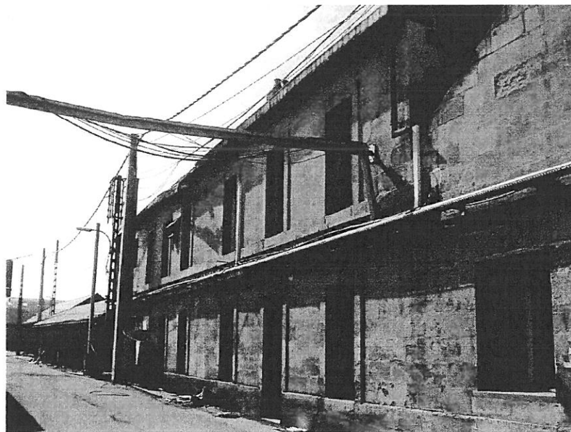
Bâtiment n°6 : Façade Nord-Est.
