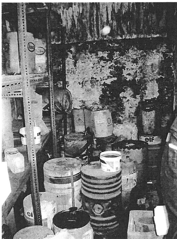
Intérieur bâtiment n°8 : Stockages divers.
