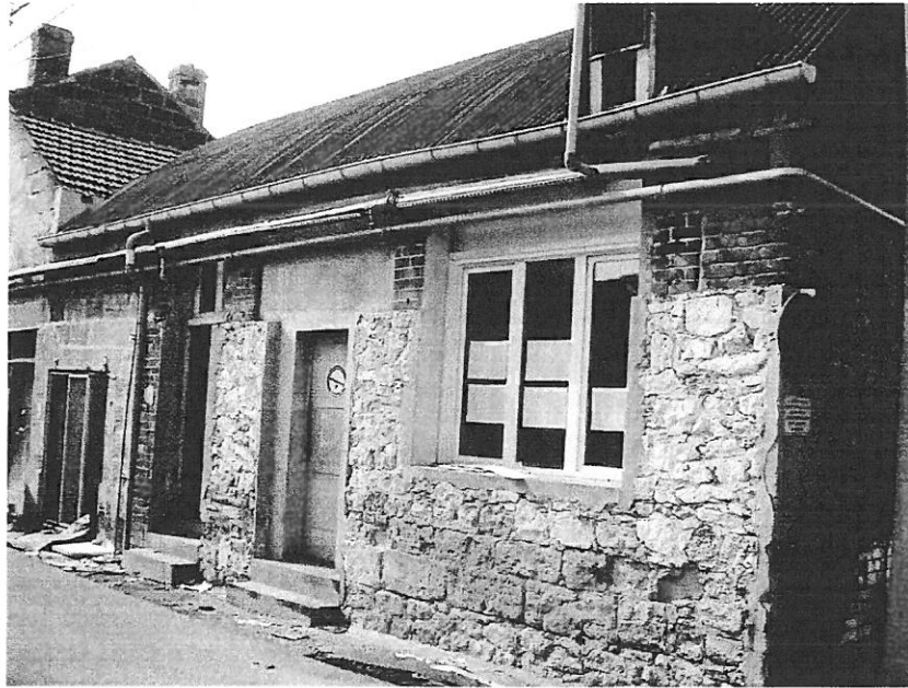
Bâtiment n°4 : Façade Nord-Est.
