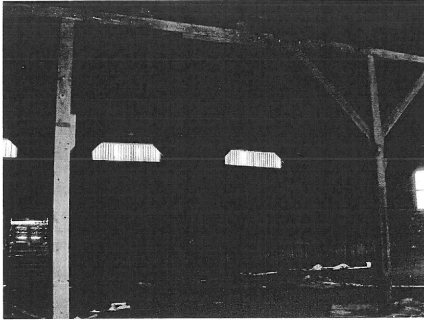
Intérieur bâtiment n°12 : Bardage et charpente.
