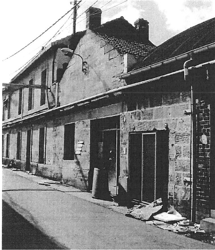
Bâtiment n°5 : Façade Nord-Est.
