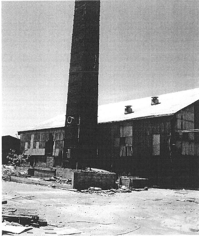
Bâtiment n°12' : Façade Sud-Est.
