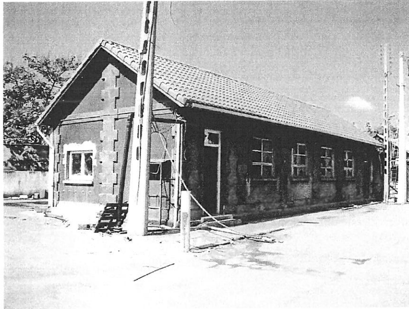
Bâtiment n°9 : Façade Nord-Est et pignon Sud-Est.
