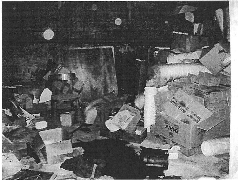
Intérieur bâtiment n°12 : Stockages divers, épanchement hydrocarbonné.
