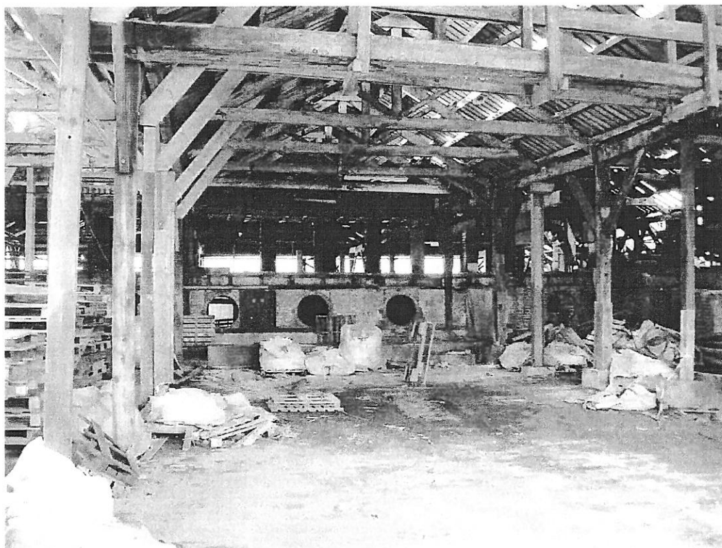
Bâtiment n°2 : Intérieur de la moitié Sud-Est.
