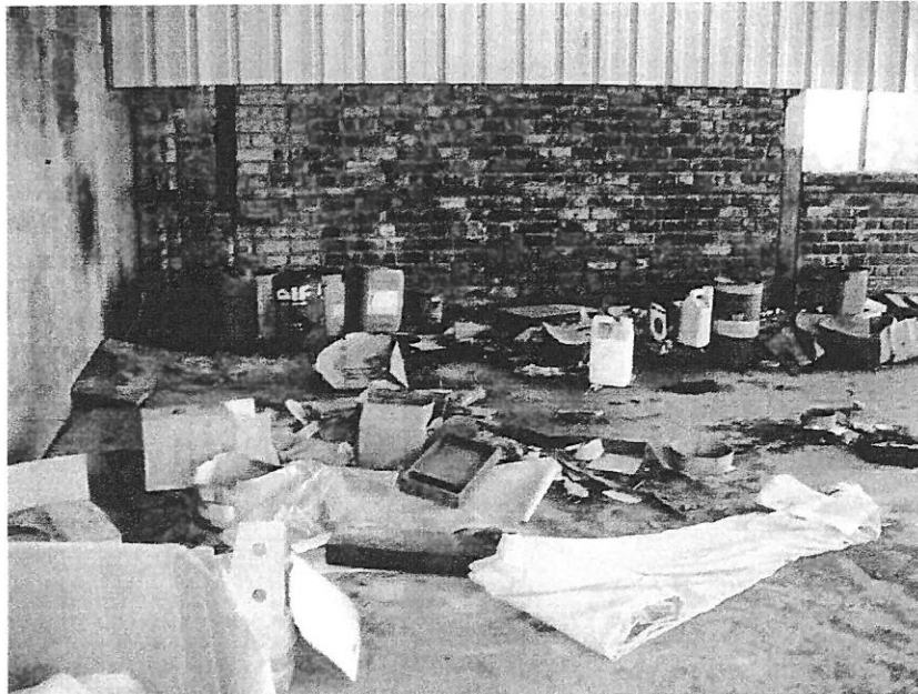
Intérieur bâtiment n°11 : Stockages divers.
